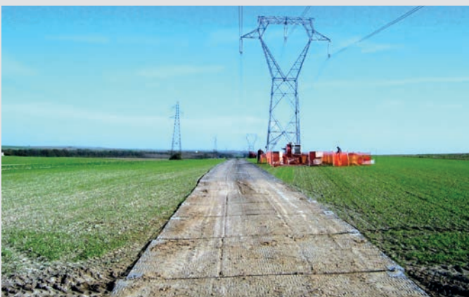
PistEco Baustraße im Einsatz für den Hochleitungsbau
