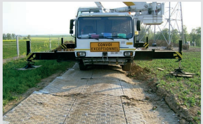
Baustellenzufahrt und Montageplattform in Einem
