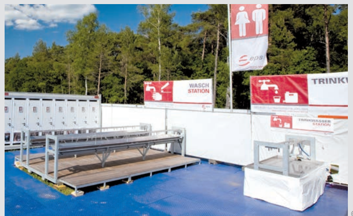
Sanitärcamp mit Trinkwasserstation
